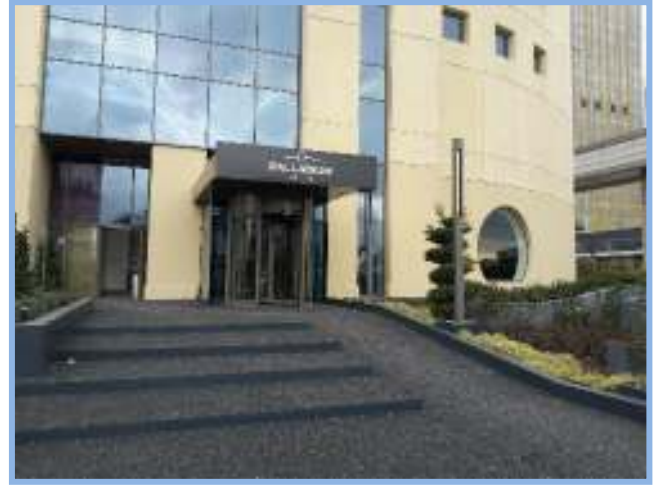
Palladium Office – A Blok – Giriş
