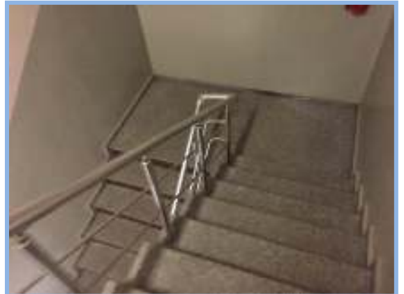
A Blok – Merdiven Boşluğu
