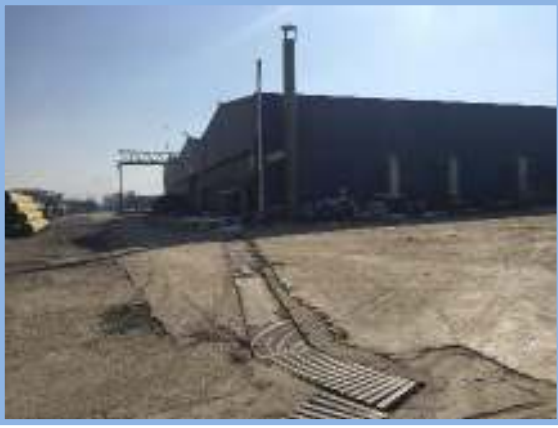
C Blok – Dış Görünüm
