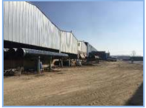
C Blok – Dış Görünüm
