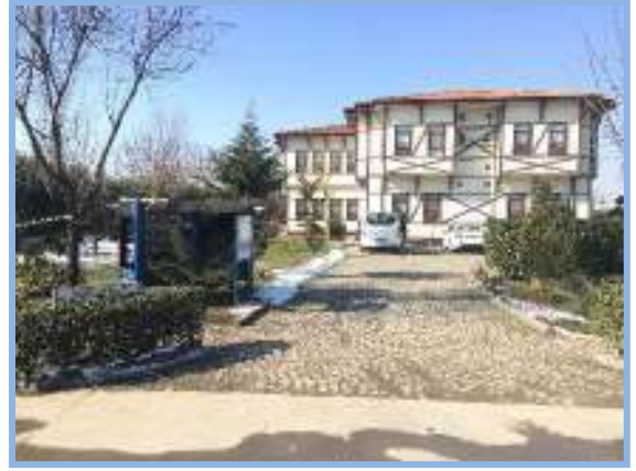
İdari Bina – Dış Görünüm
