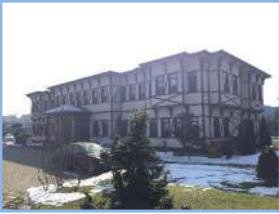
İdari Bina – Dış Görünüm
